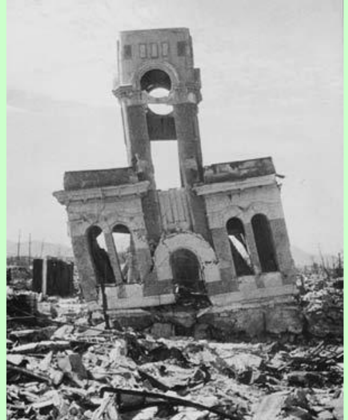
爆炸冲击导致的奇怪后果：水泥建筑的第一层坍塌以后，第二层和钟塔依然屹立着。
