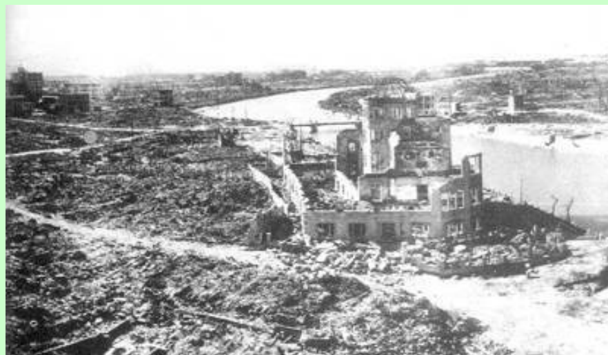
大多数建筑物倒塌
